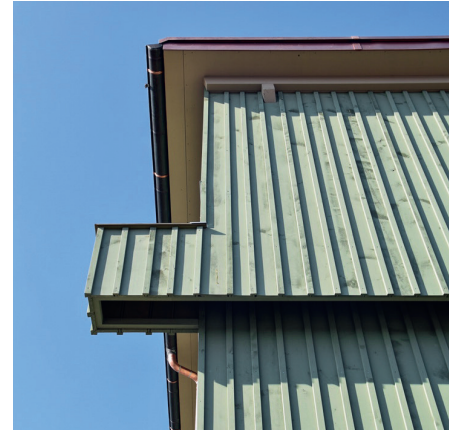
Die Schnittkanten waren besonders sorgfältig zu beschichten.
