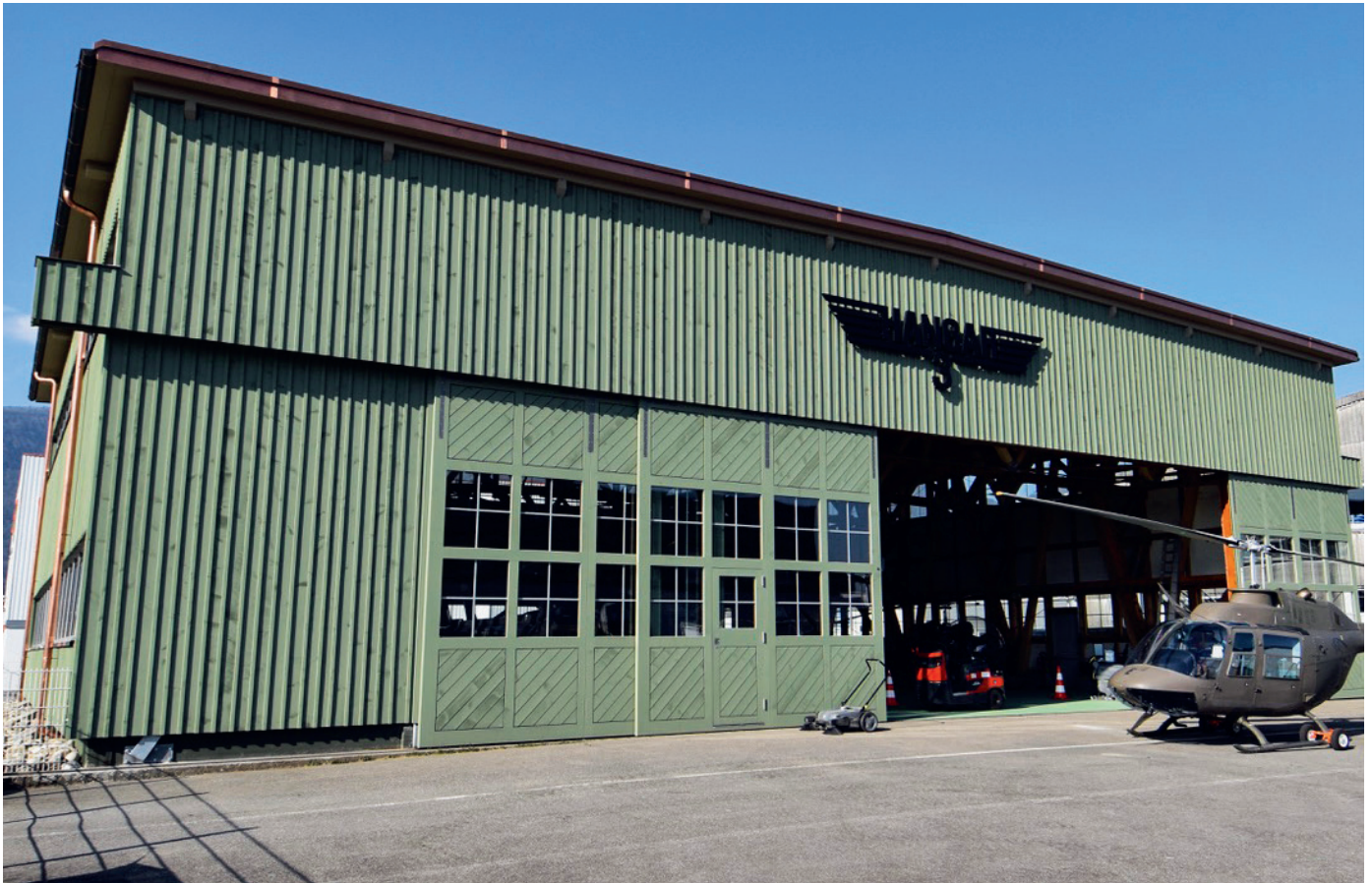
Der Hangar 3 auf dem Flughafen Grenchen. Die Holzstruktur ist trotz der Beschichtung gut zu erkennen.
