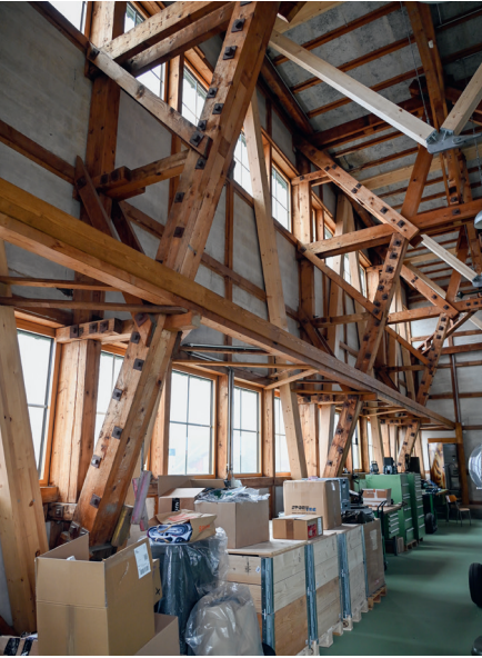
Die alte Holzkonstruktion im Innern wurde nur gereinigt.
