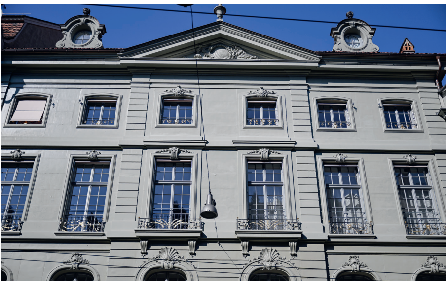
Die renovierte Fassade der Kramgasse 72.
