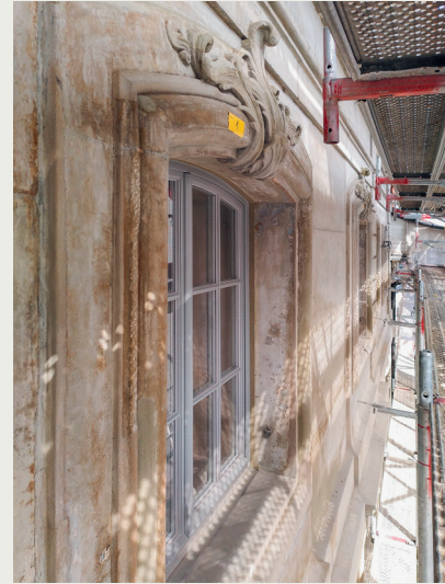
Die Farbe ist weg und der rohe Sandstein parat für die neue Beschichtung. Bild: Thymos AG
