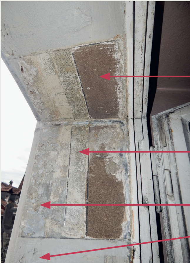
Kartierung der um 1993 durchgeführten Sanierungsmassnahmen: Gelb: Neue Natursandsteinerersatzstücke. Rot: Ausgespitzt und mit Kalktrassmörtel aufmodelliert. Grün: Reinigung. Bild: zVg
