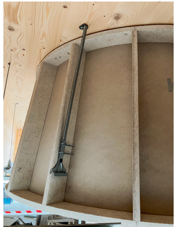
Noniusabhängiger verbindet die Formteile direkt mit der Holzkonstruktion.
