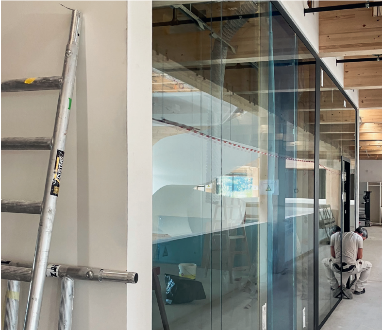
Glaselemente trennen Besprechungszimmer und andere Räume.
