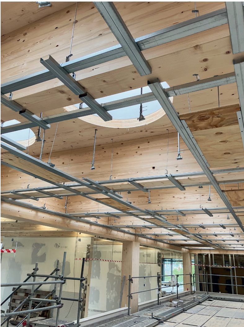
Die abgehängte Decke an der Holzdecke mit den Oberlichtern.
