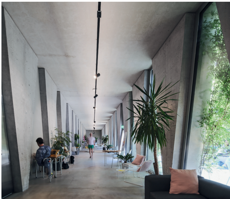
Beim Tanzhaus in Zürich sind alle Innen- und Aussenwände in Sichtbetonqualität ausgeführt. Bild: Giuseppe Micciche
