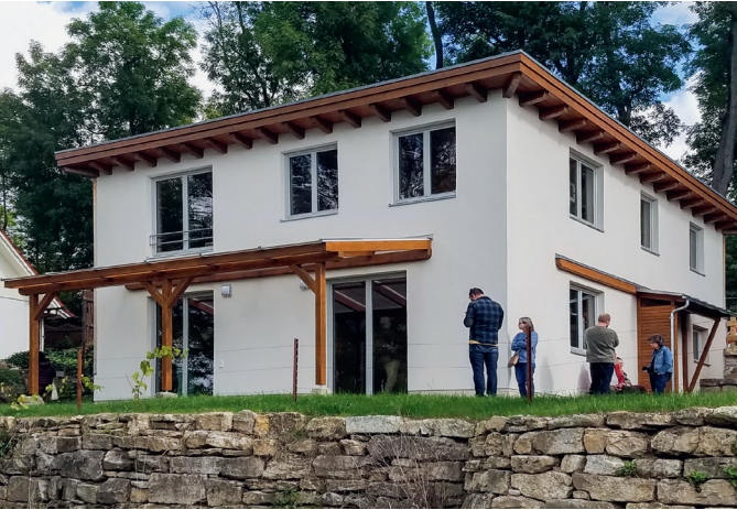
Vorgefertigte Module aus Holzrahmen, die mit Stroh ausgefacht werden, kamen bei diesem Einfamilienhaus in Illmenau zum Einsatz. Bild: Achim Pilz
