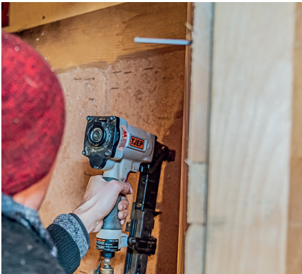
Lehmbauplatten können mit Holznägeln befestigt und auch getackert werden. Bild: Christian Tharovsky
