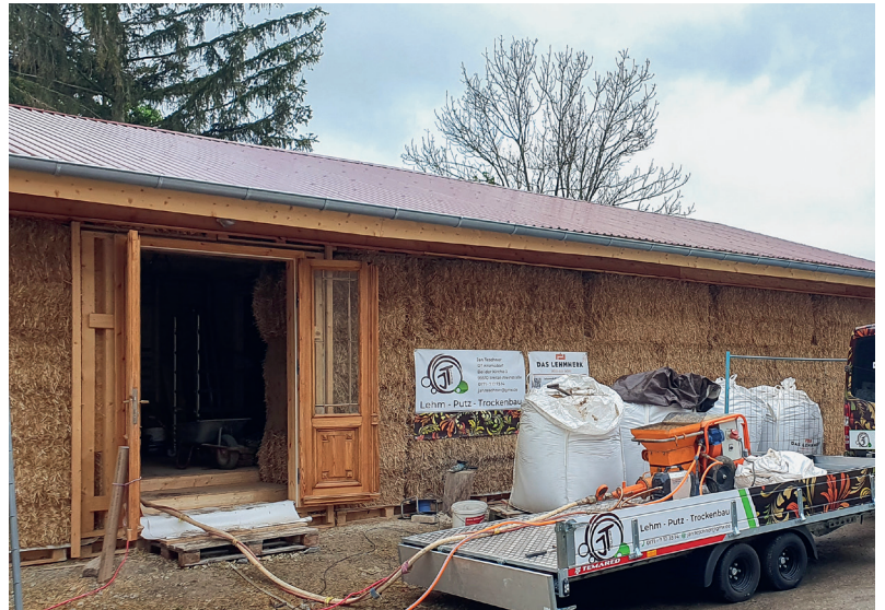
Am Gebäude in Holzdorf wurden als Erstes die klaffenden Fugen zwischen den 400 kg schweren Ballen mit Strohlehm ausgestopft. Bild: Lehm.Putz.Trockenbau
