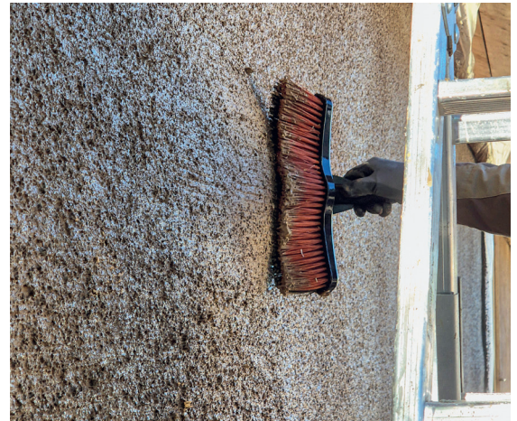
Geschützt von einem grossen Dachüberstand erhielt der raue Oberputz aussen einen Besenstrich und blieb lehmsichtig. Bild: Lehm.Putz.Trockenbau
