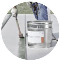
Revêtement de protection anticorrosion
