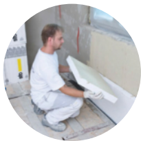
Isolation thermique intérieure
