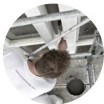
Rivestimenti interni ed esterni
